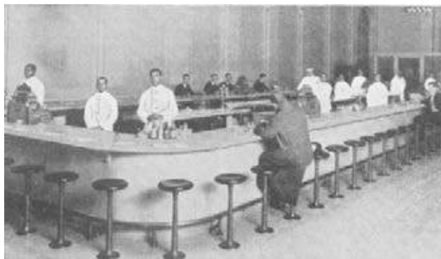
Dans les bars où l'Américain habitant les grandes villes prend très souvent ses repas, la cuisine a pour base les grillades, les conserves et les sauces toutes préparées. (Phot. Wide World.)
