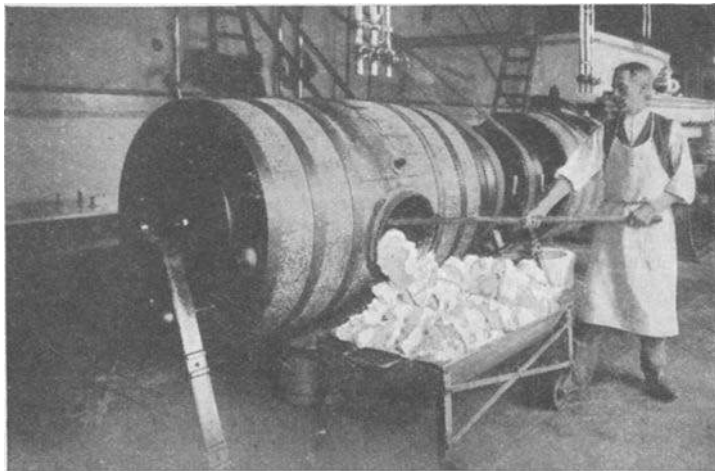
Grande baratte mécanique dans une beurrerie coopérative.
