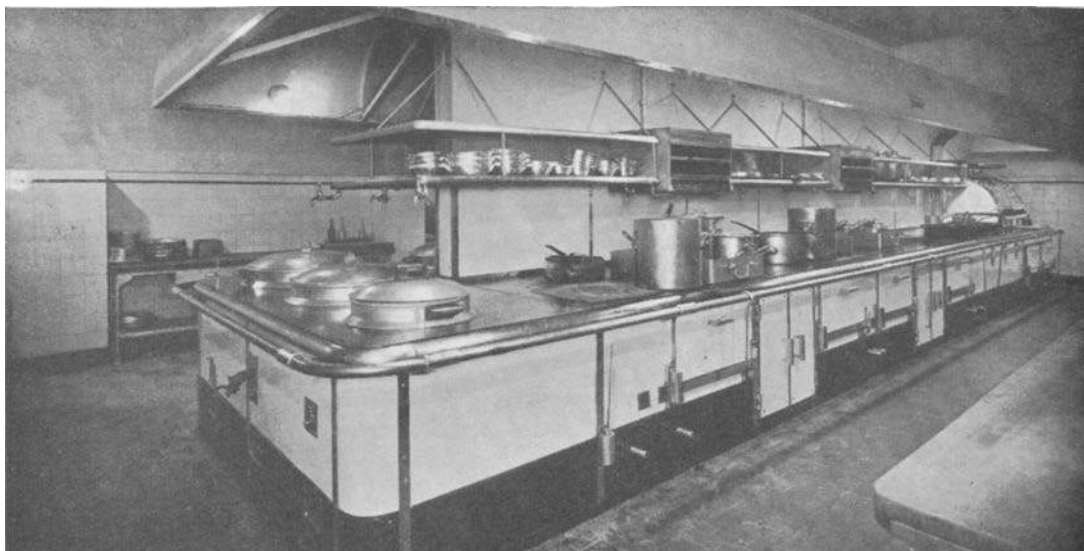
Une cuisine de grand hôtel équipée au gaz. On voit à gauche les bains-marie ; au centre et en haut deux salamandres ; à droite au fond les grills. (Hôtel Ambassador. Phot. C* g du gaz de Paris.)
